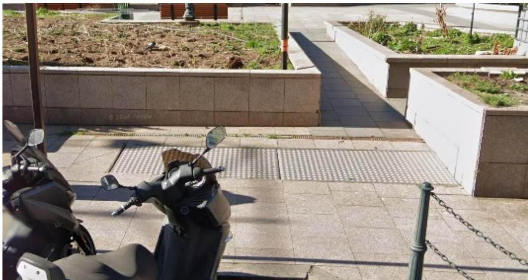
Figure 13: Trappes d'accès à rehausser
