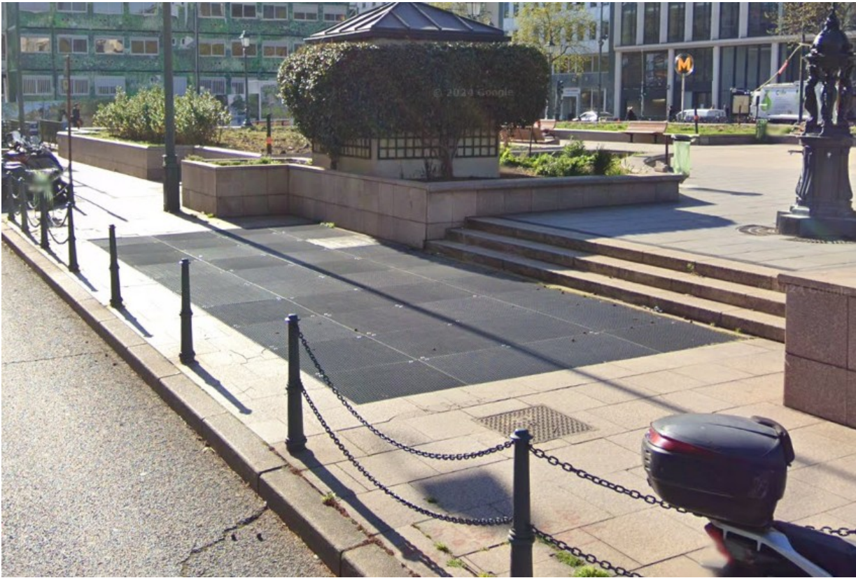
Figure 12: Grilles de ventilation à rehausser
